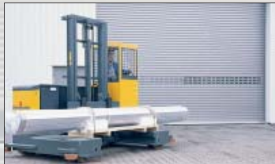
Het roldeurpantser kan met behulp van een heftruck op de gemonteerde consoles geplaatst worden.
