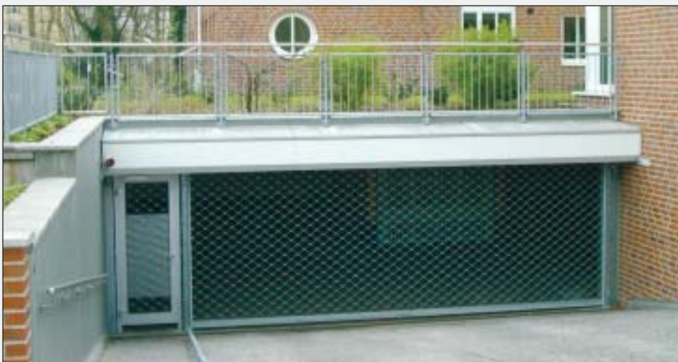
Rolhek met zijdeuren in een kelder.
